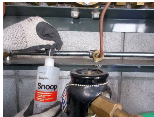
検知液での漏洩検査
