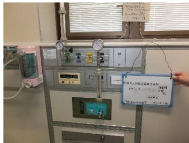
配管端末器点検
