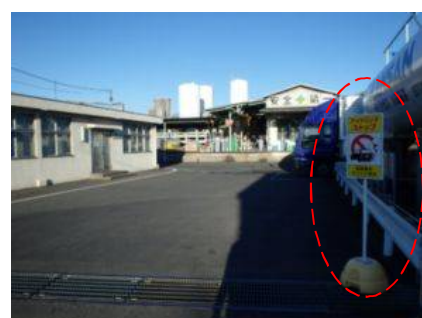
駐車スペース付近－3
