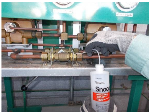
検知液での漏洩検査
