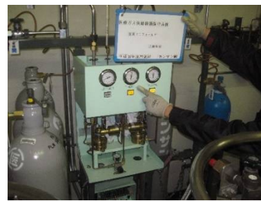
供給装置点検状況
