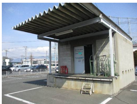
駐車場設置の保管庫
