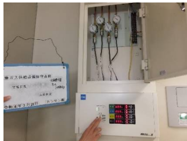
警報装置点検状
