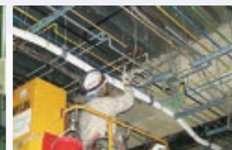
新設工事風景
