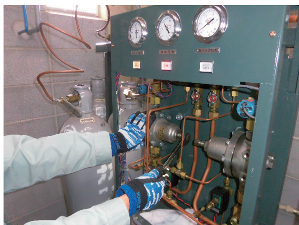
図10 窒素供給装置点検状況
