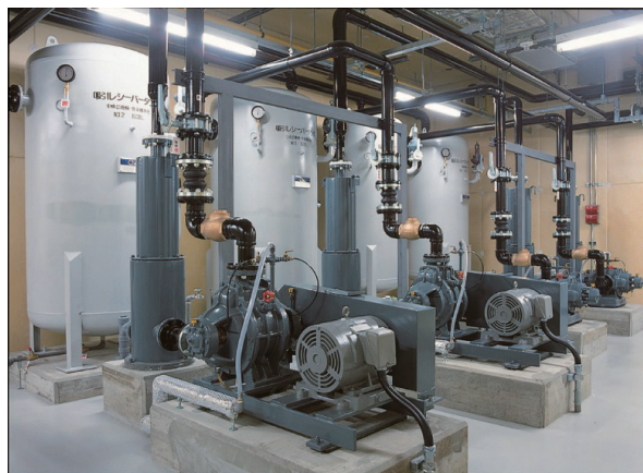
図2 吸引供給設備例
