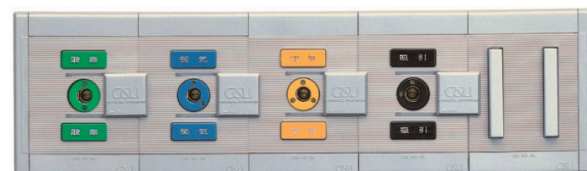
図5 配管端末器 識別色例
